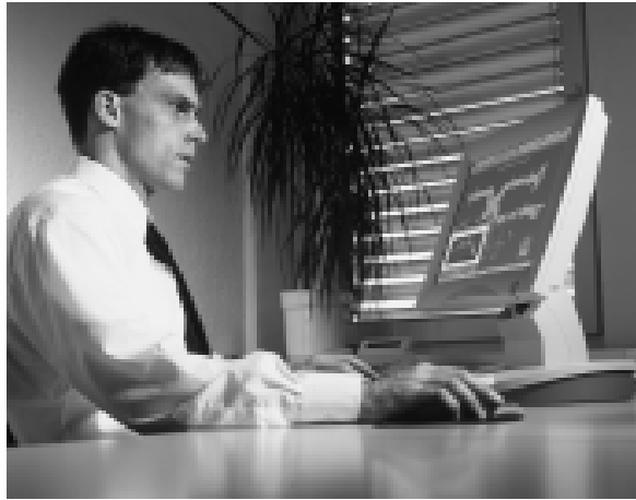
станция управления DESIGO INSIGHT
